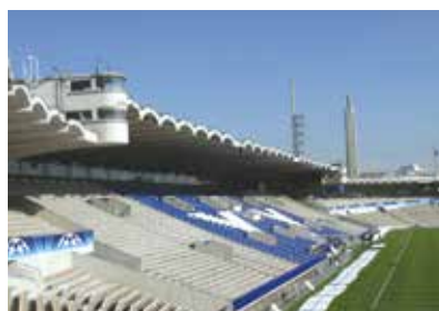
■ Réhabilitation structure BA complexe Stade Chaban-Delmas à Bordeaux
