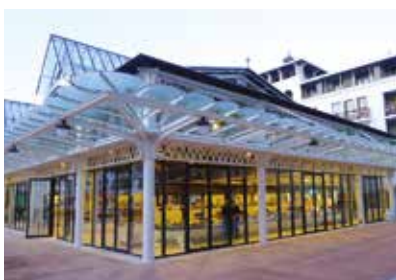
■ Façade technique et charpente métallique complexe Marché Arcachon (33)
