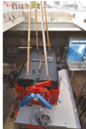
■ Mise en place chaufferie bois 2.5 MW - © ENB
