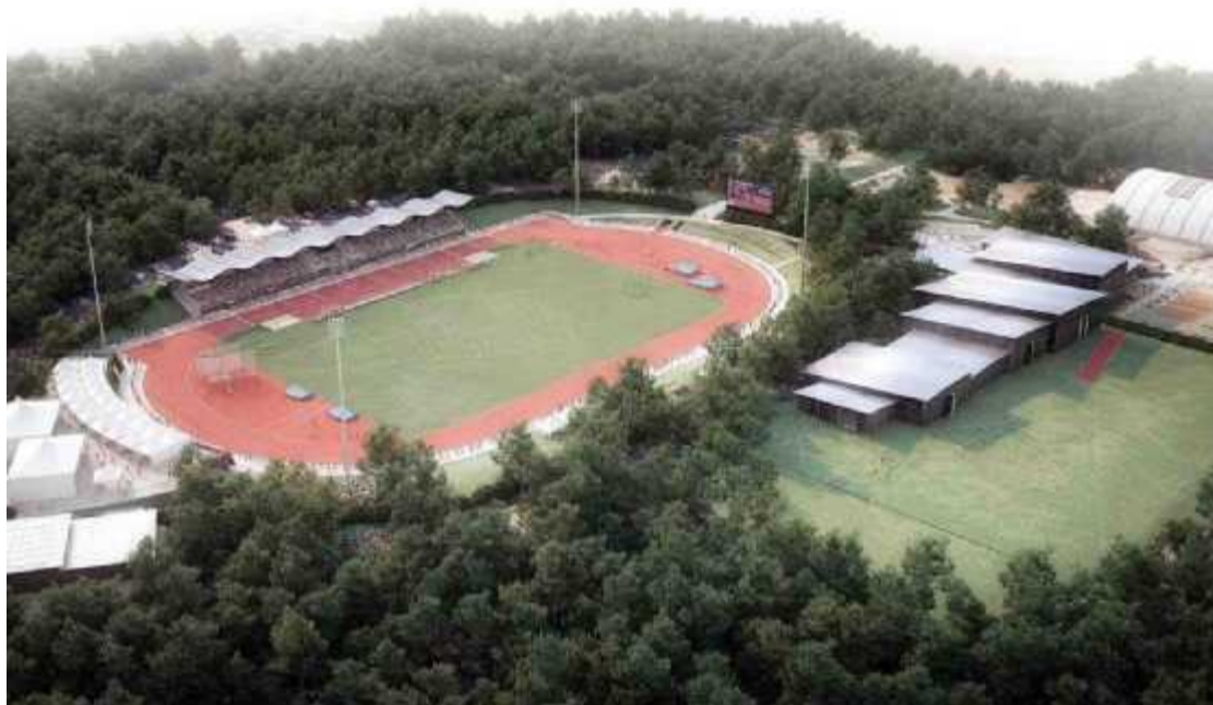
Les travaux du projet de réhabilitation du stade Pierre-Paul Bernard débuteront à l'été 2020.
