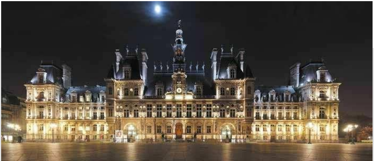
Assistance à Maîtrise d'ouvrage Ville de Paris
